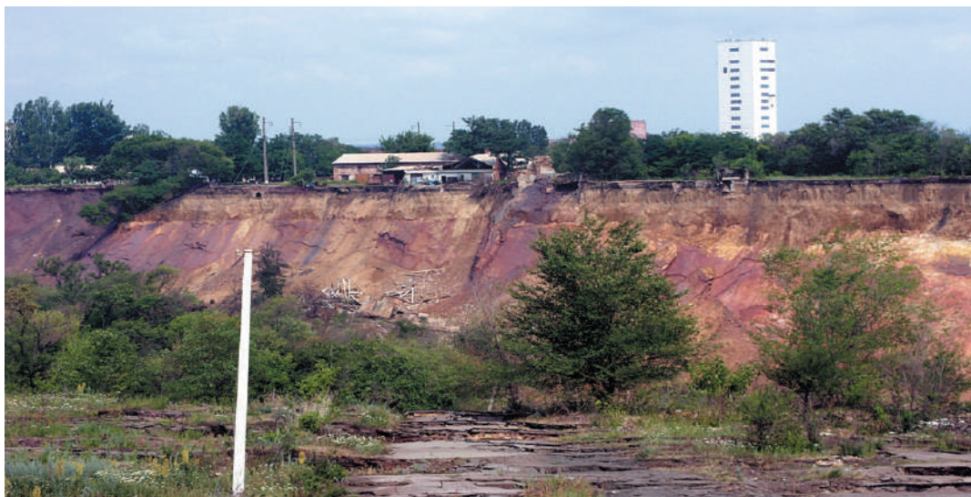
Рис. 3. Загальний вигляд провалу денної поверхні на Кривбасі на полі шахти ім. Орджонікідзе (світлина І. М. Малахова)
